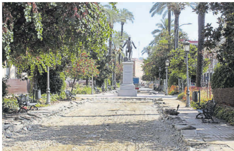
El pavimento del paseo central se ha levantado, a la espera del permiso de Patrimonio para excavar.
